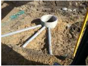
Fig. 1 Plaatsing betonnen infiltratieput met aanvoer HWA-riool
