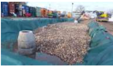
Fig. 2 Aanvullen infiltratie systeem met granulaat
